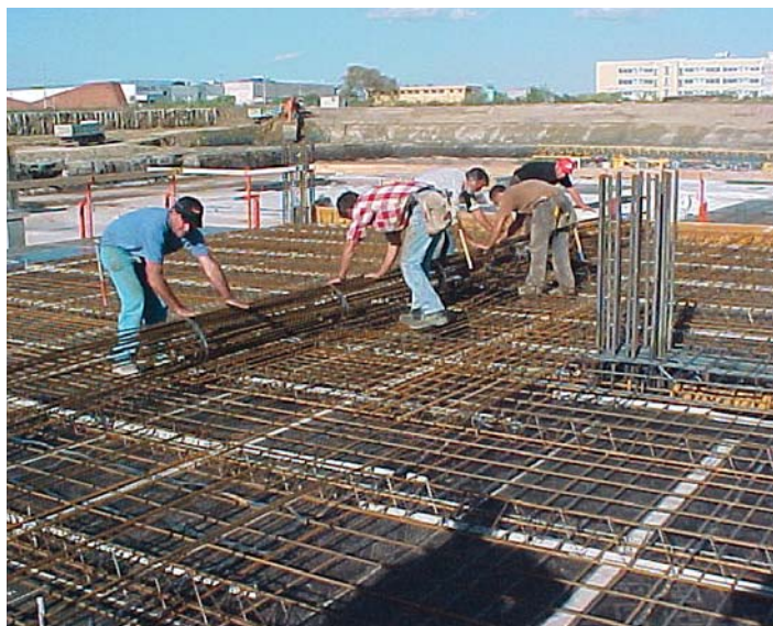
EDIFICIO POLIFUNZIONALE – Fiumicino, Roma Impresa costruttrice: C.D.C. Cooperativa di costruzioni
